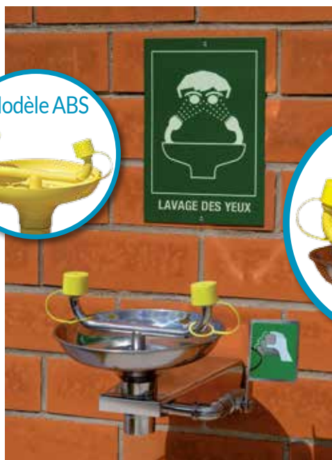
2210 LAVE-YEUX MURAL avec vasque ABS existe en modèle SS existe en modèle TI
